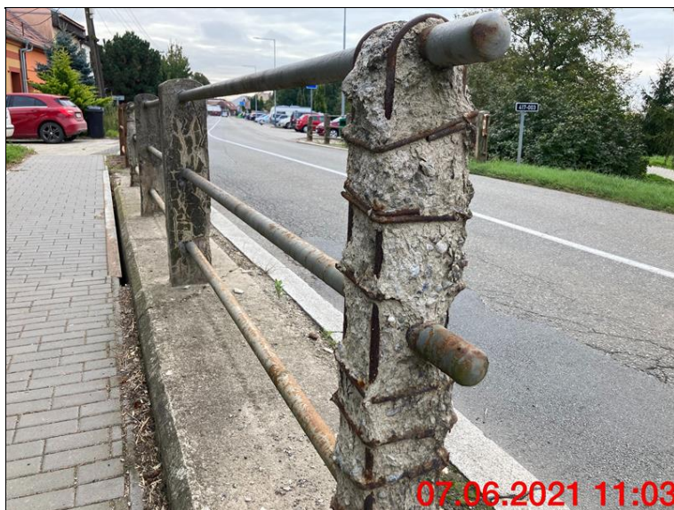
05.Rozpadající se sloupek zábradlí na levé straně mostu.JPG
