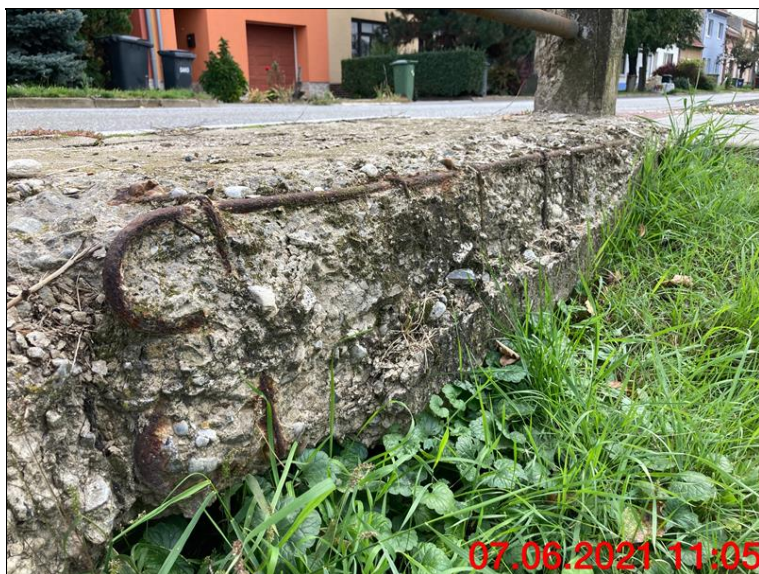
10.Obnažená výztuž římsy vpravo.JPG
