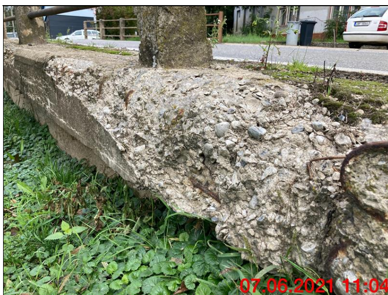
09.Rozpad římsy na pravé straně.JPG
